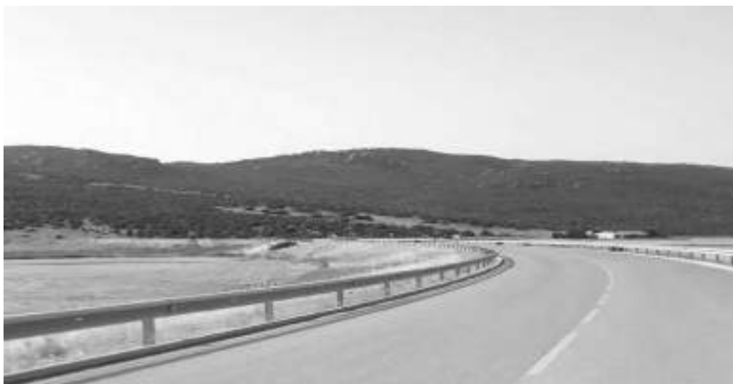
Fotografía 16. Carretera A-2227 de camino al cruce con la CA-6203, variante de Zahara de los Atunes.
