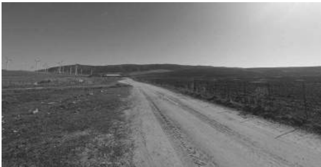
Fotografía 3. Camino de acceso a la instalación fotovoltaica.
