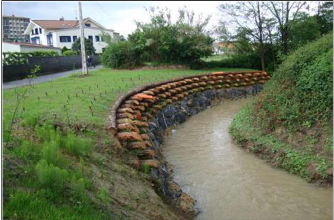
Muros Krainer tipología para la laguna de infiltración.
