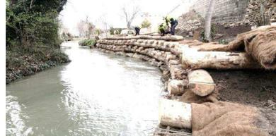
Muro Krainer tipología para la laguna de infiltración.
