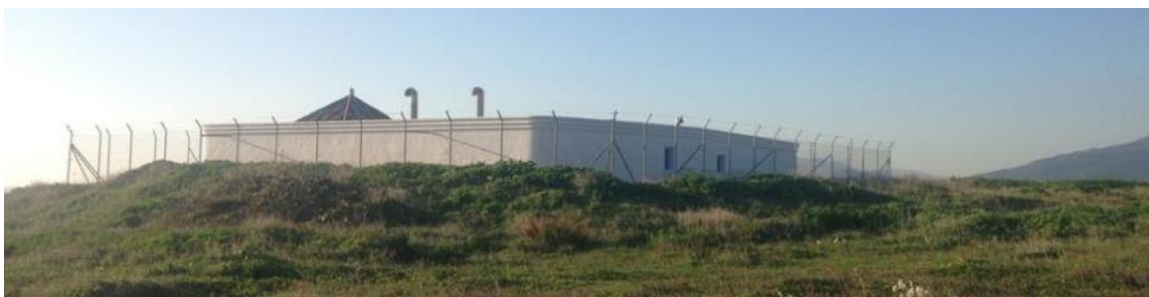
(C) Depósito de agua potable situado en las cotas superiores.
