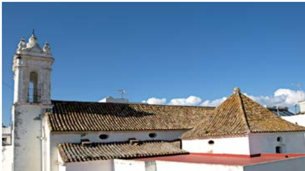
Cubiertas de San Francisco, vistas desde el sur (APM)
