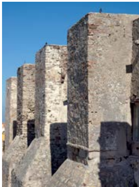
Torres del frente Sur con refuerzos en su base (APM)
