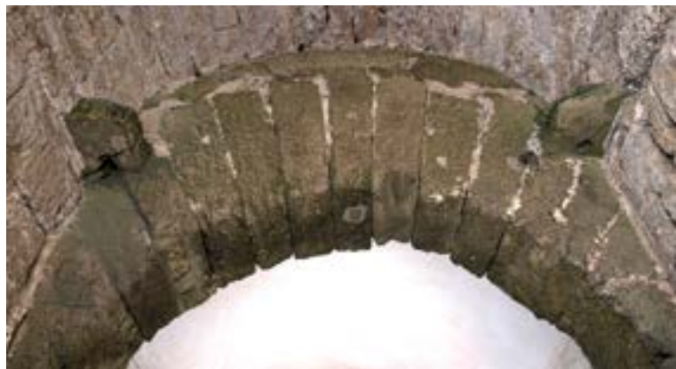
Quicaleras superiores en el arco interno de la Puerta de la Inscripción (APM)
