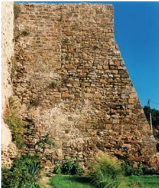
Lateral de la Torre de los Maderos, en la que podemos observar la superposición de fábricas (APM)
