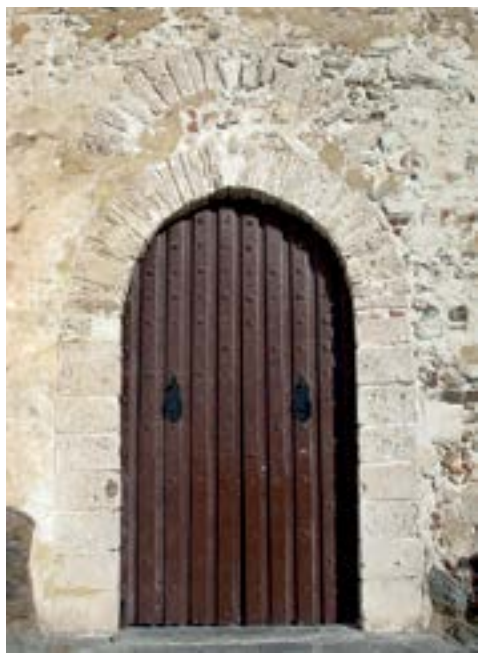
La otra Puerta del Mar, actual acceso al castillo (APM)
