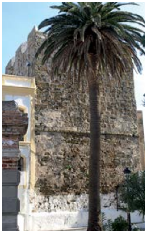
Torre de San Sebastián, en la esquina noroeste (APM)
