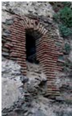
Arco de salida de un desagüe, abierto en la muralla, junto a la Torre de los Maderos (APM)
