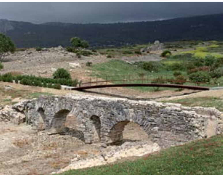
Acueducto salvando el arroyo de las Chorreras (APM)
