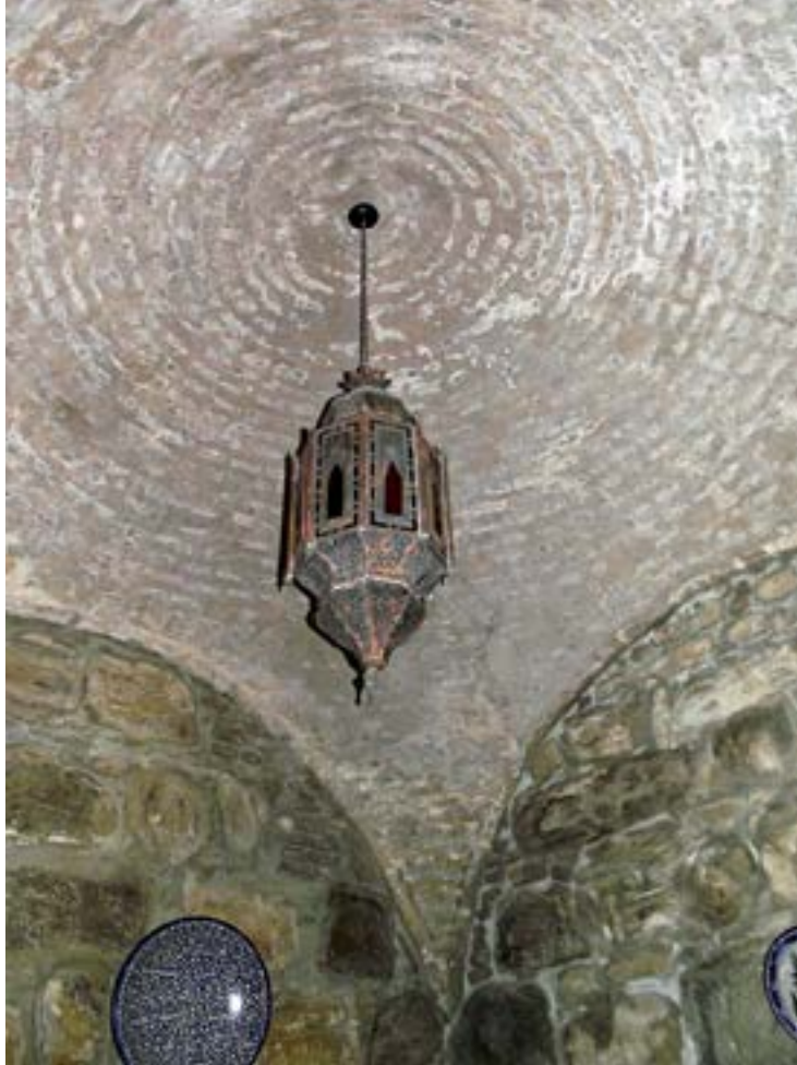
Bóveda de una cámara situada en una torre del Arrabal (APM)
