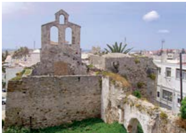
La nave, capillas laterales y presbiterio del templo, en ruinas, precisarían una excavación arqueológica para definir su planta (APM)
