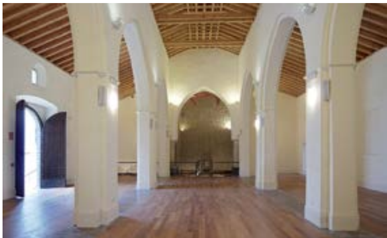
Interior de la Iglesia de Santa María, tras su rehabilitación (MR)
