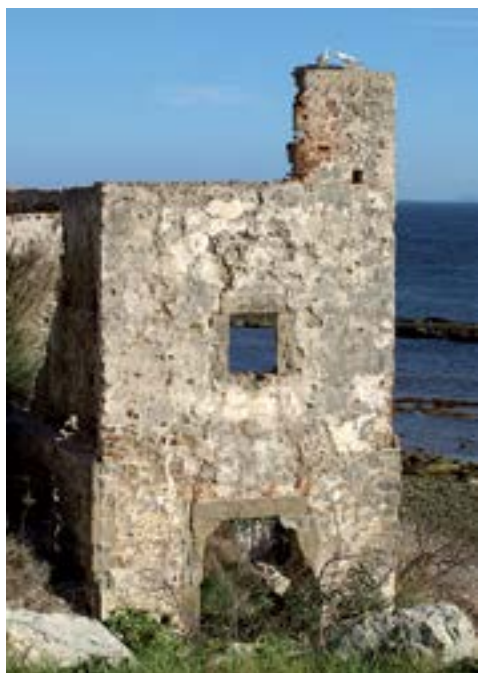
Ruinas de antiguas instalaciones portuarias en la Caleta (APM)
