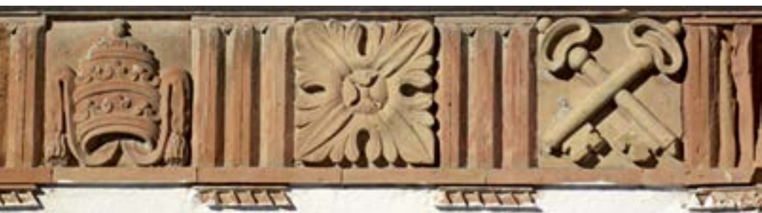
Ladrillos en relieve con la tiara y llaves de San Pedro, visibles en la fachada del Sagrario hacia calle Padre Félix (APM)
