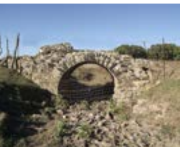
Puente romano sobre el río Salado (APM)
