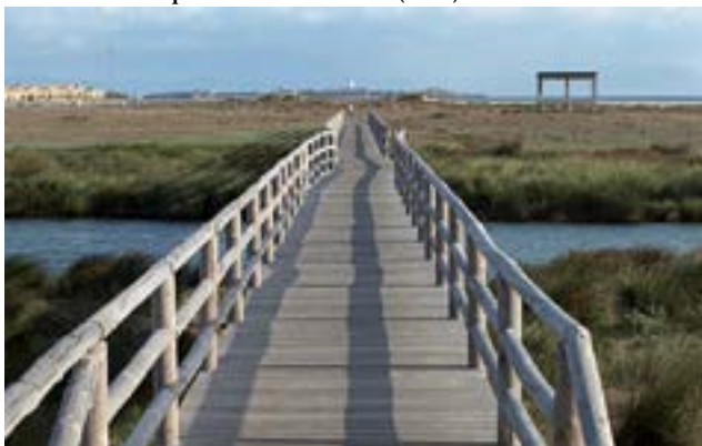
Pasarela en el Parque Natural del Estrecho (APM)
