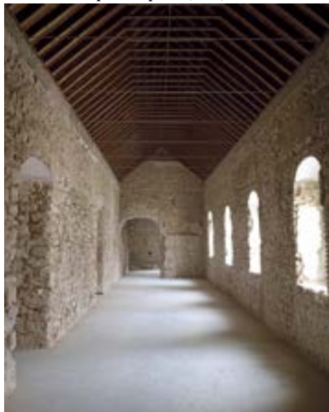
Sala Norte de la planta superior (APM)
