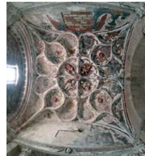
Bóveda de la capilla del Hospitalito (MR)
