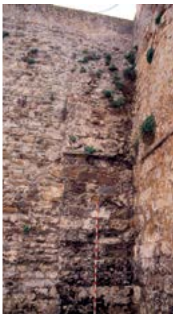
Detalle de la unión entre una torre califal y la Torre del Homenaje (APM)
