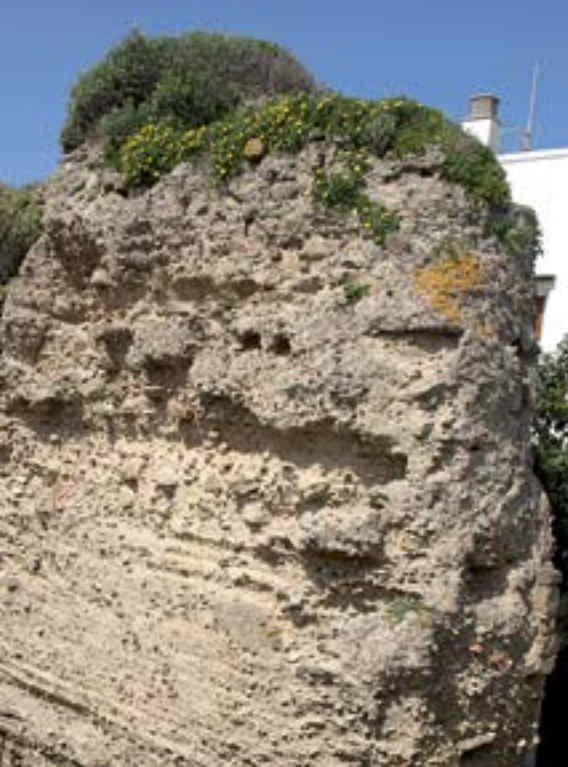
La Torre del Macho vista desde la Casa de la Cultura. Se distingue el tapial que la conforma (APM)
