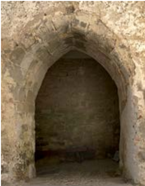
Arco apuntado de sillería al interior de la Puerta en Recodo, en el frente occidental del castillo (APM)
