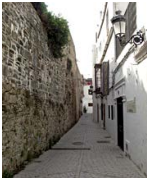
Calle Independencia, al interior de la muralla (APM)
