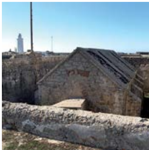
Polvorín subterráneo (APM)
