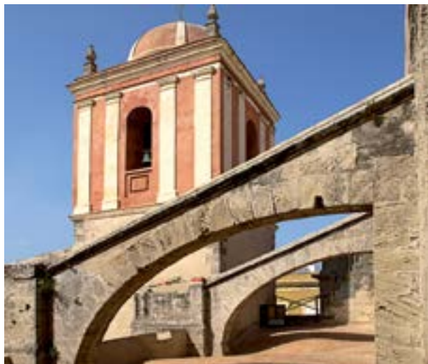
Arbotante y campanario de la iglesia de San Mateo (APM)
