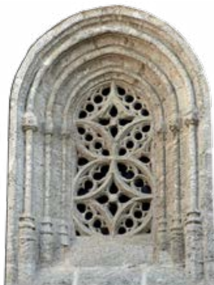
Ventana gótica con celosía de piedra calada (APM)
