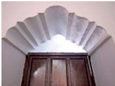
Arco de acceso a la parte alta (APM)
