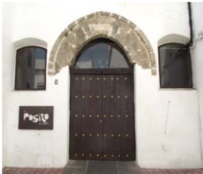
Puerta gótica de acceso a la antigua carnicería, en calle Santísima Trinidad (APM)
