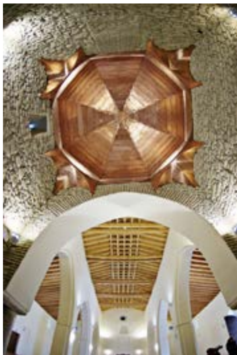
Cubiertas reconstruidas (MR)
