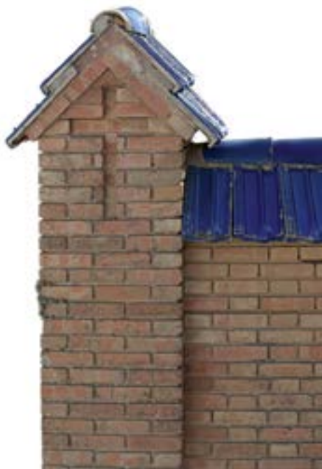
Detalle del muro de entrada al cementerio (APM)
