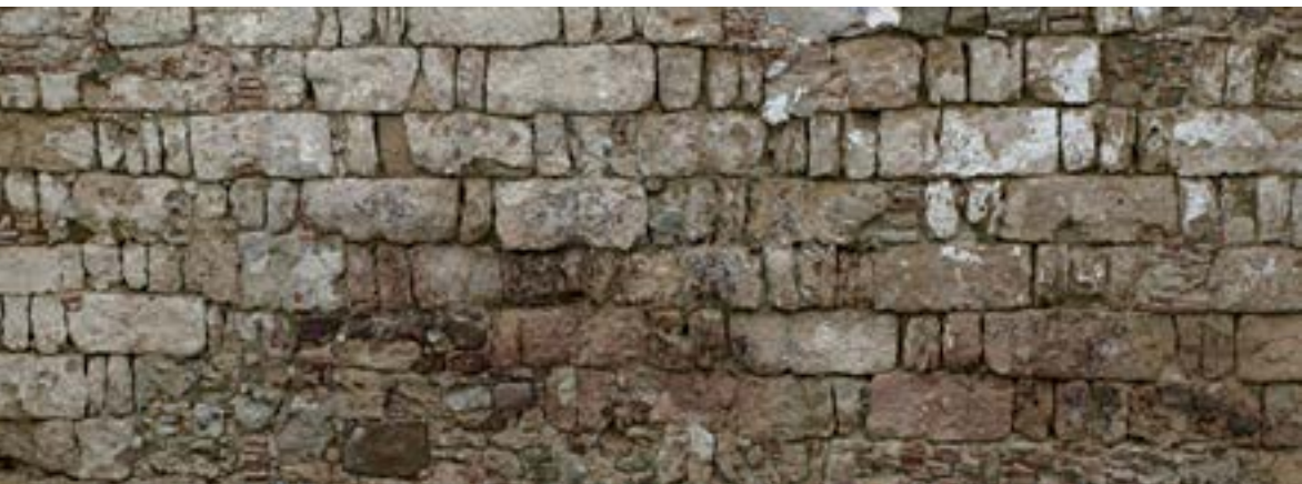
Aparejo califal “a sogas y tizón” en el patio oriental de la alcazaba (APM)
