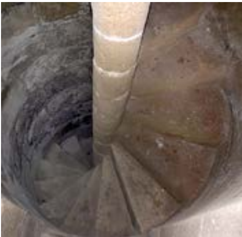
Escalera gótica de abanico (APM)
