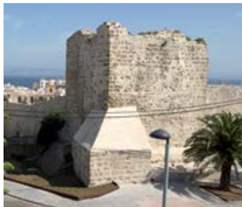
Torre del Corchuelo, en el ángulo NE de la muralla (APM)
