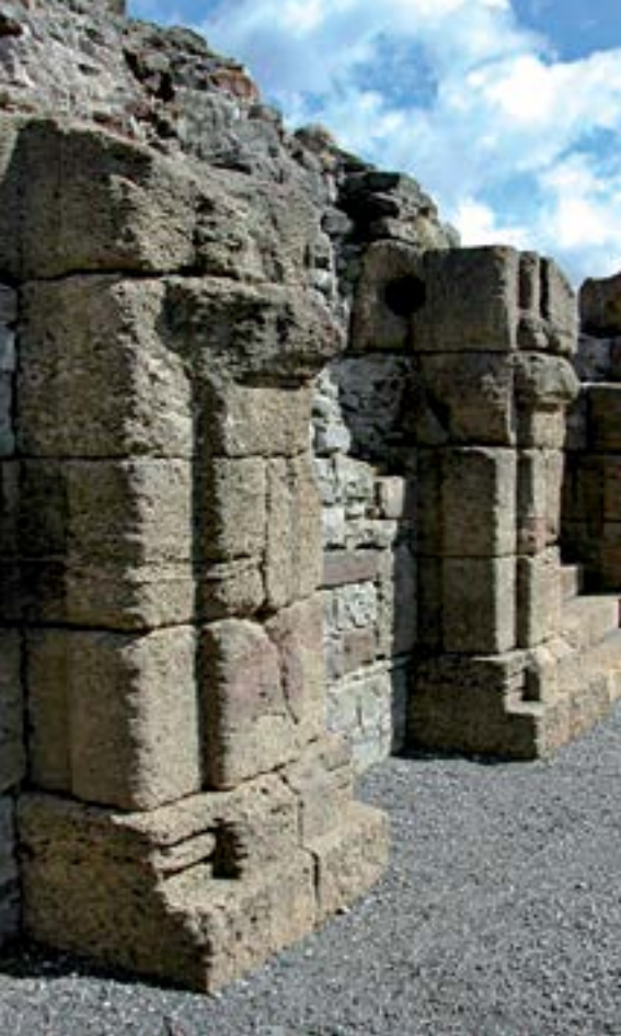
Muro del parascaenium oriental del teatro (APM)
