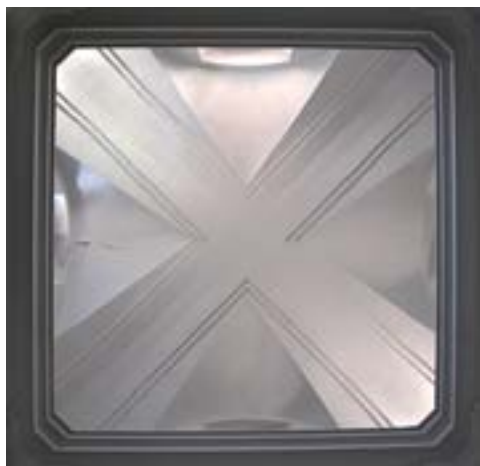
Bóveda del Sagrario (APM)
