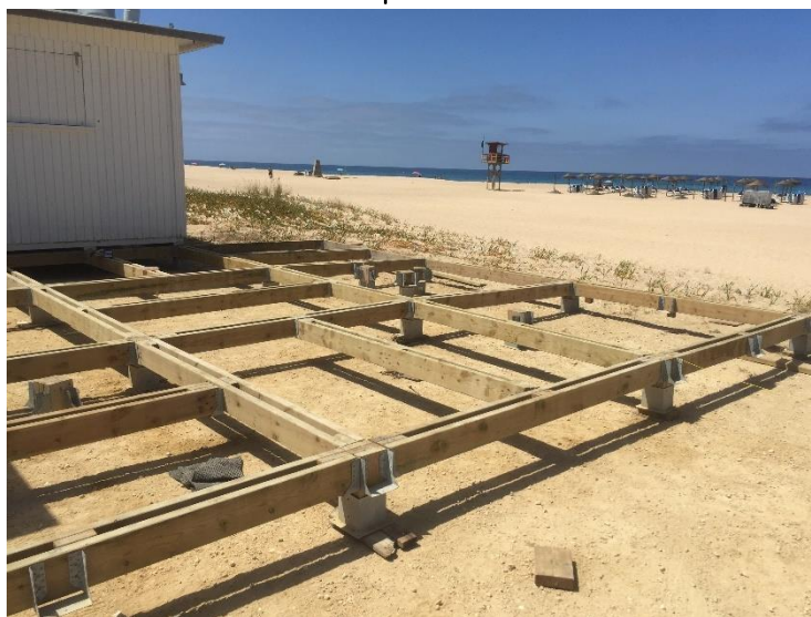
Foto tipo de cimentación
