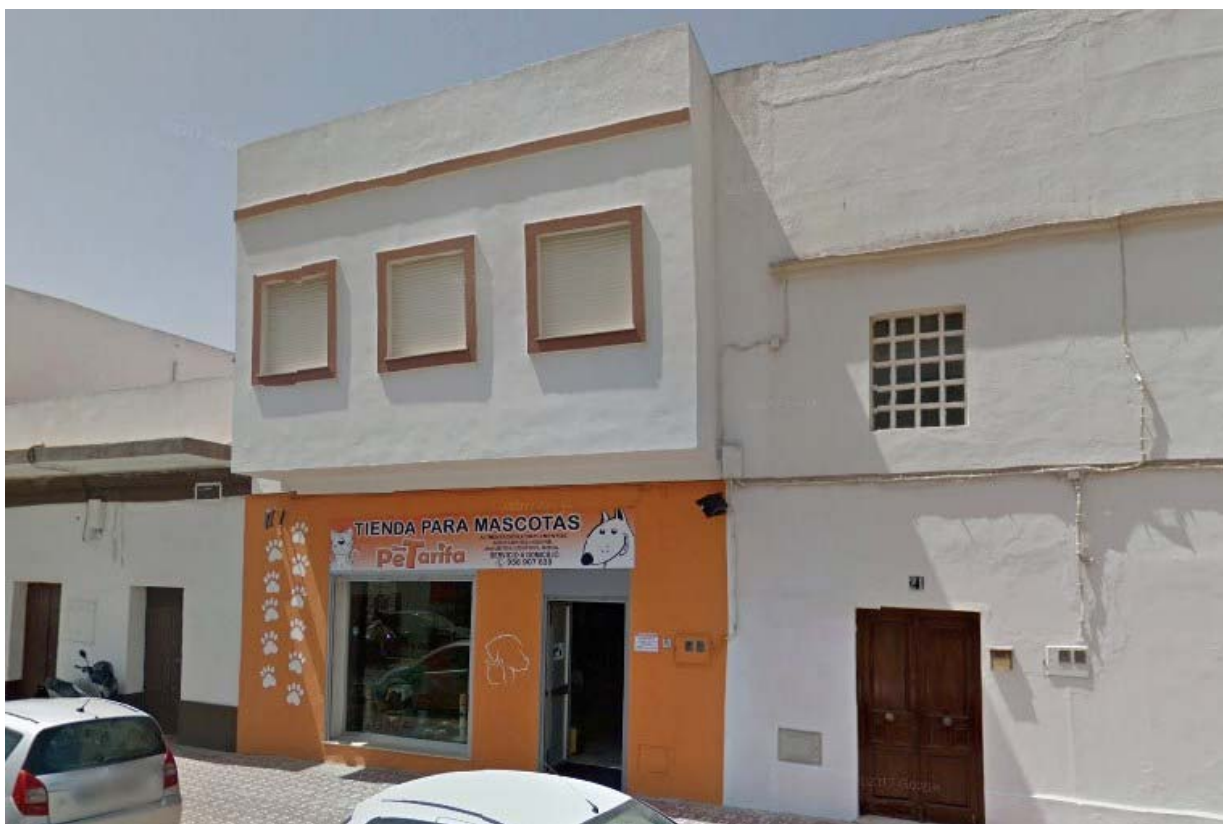
Fachada del Establecimiento y Vista General
