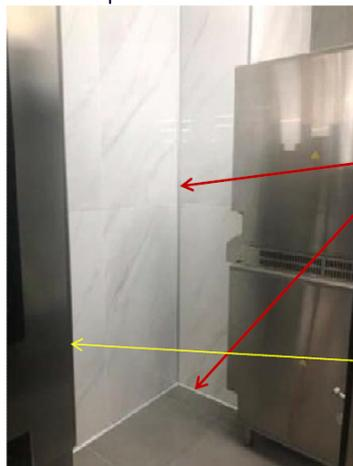
ESCOCIA Emac, de Aluminio plate mate – nº5. Colocación vertical ángulo cerrado y unión pavimento, con piezas especiales – alicatado Lenci.
