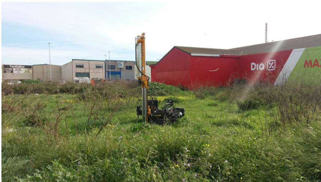
Emplazamiento del ensayo penetrométrico DPSH reseñado como P-2.
