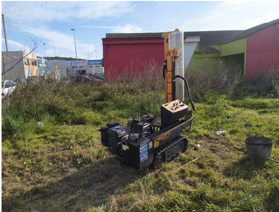
Emplazamiento del ensayo penetrométrico DPSH reseñado como P-1.
