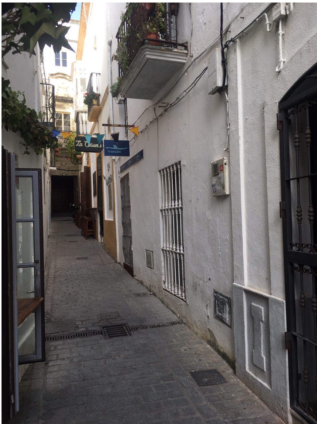
Fachada del local
