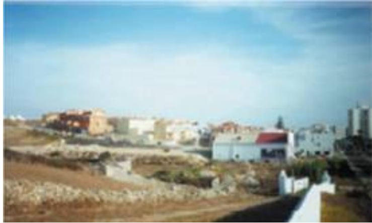
Imagen del crecimiento norte del núcleo, caracterizado por la implantación masiva y dominante de viviendas unifamiliares adosadas.
