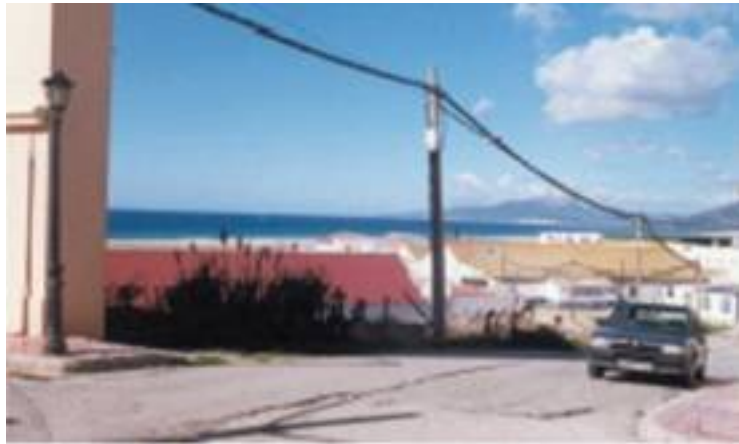
Sin embargo, la desestructuración del sector se evidencia en la confluencia del trazado urbano reticular con asentamientos pseudoindustriales que conforman la fachada a los Lances, generando espacios intersticiales marginales al no haber resuelto adecuadamente la transición topográfica hacia el frente marítimo, mediante operaciones regenerativas de espacio público.
