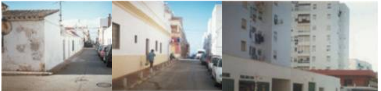
Las imágenes revelan un sector de la ciudad de fuerte caracterización, con presencia dominante de la edificación alineada a vial, y que se encuentra en proceso progresivo de transformación con la aparición de la tercera planta, básicamente, en los ámbitos de contacto con la c/Batalla del Salado y Avenida de Andalucía. Junto a ellos conviven algunos espacios que aun conservan sus características originales, con edificaciones unifamiliares de 1 ó 2 plantas y construcciones pseudoindustriales.
