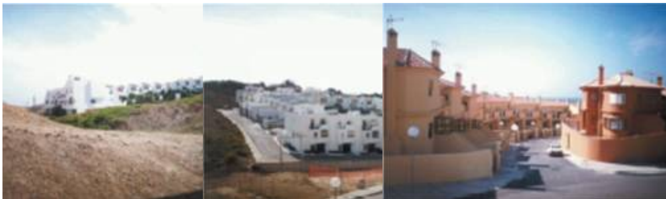
Vistas de los desarrollos de las Unidades de Ejecución llamadas a definir el crecimiento norte del núcleo.
