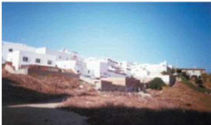
Suelo urbano consolidado, colindante con el Sector de Suelo Urbanizable Programado S4 "El Olivar".
