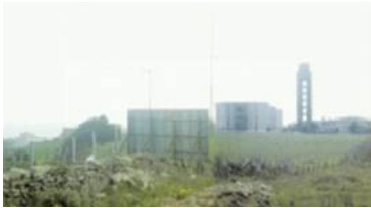
Sector S4 desde acceso Este de la CN 340
