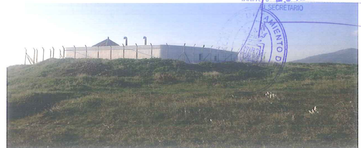
Imagen del depósito de agua potable situado en las cotas superiores.
