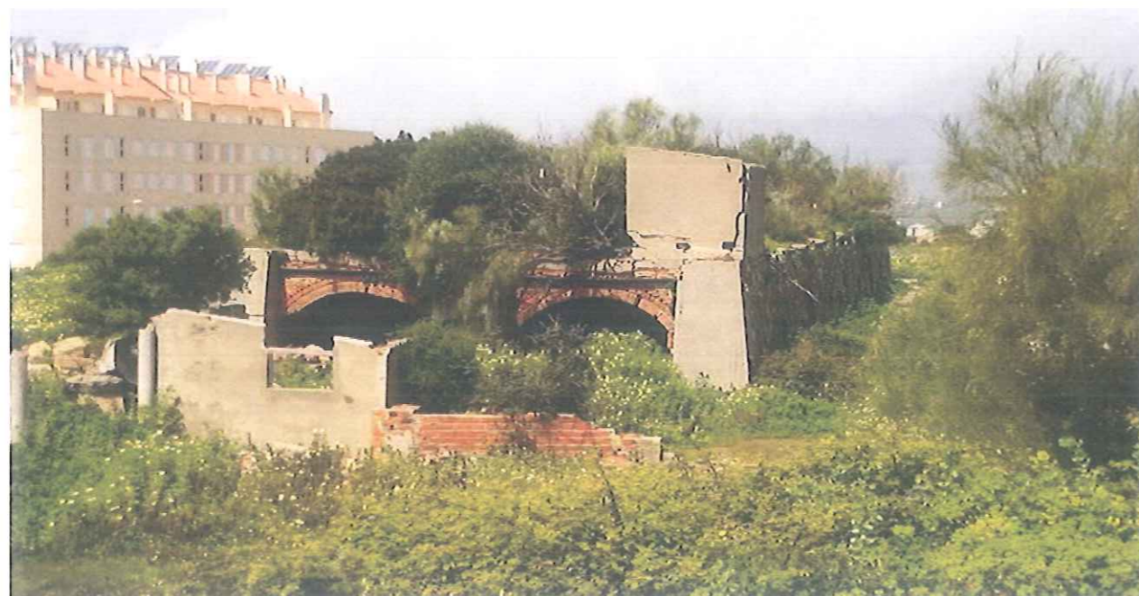
Imagen de antiguas construcciones en mal estado de conservación.
