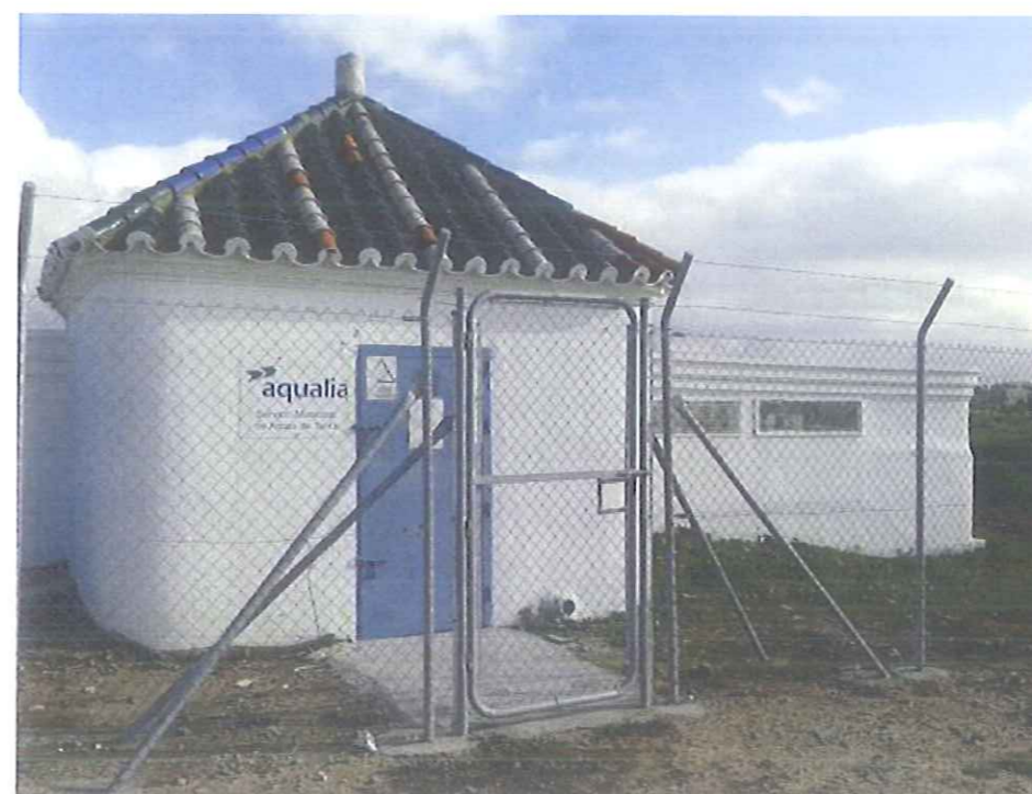
Fotografía 2.2. Depósito de agua municipal localizado en el ámbito de actuación.
