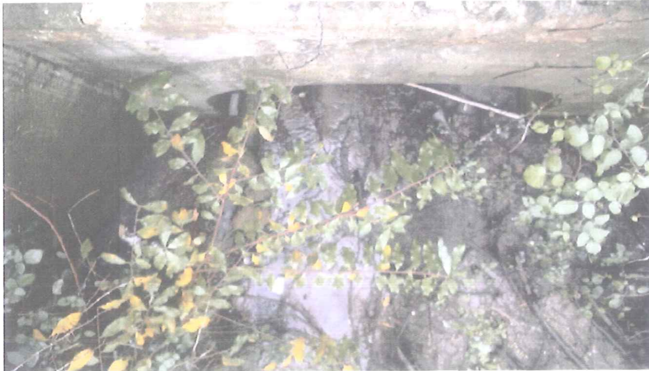
Imagen del inicio del entubamiento del arroyo Innominado N°1.
