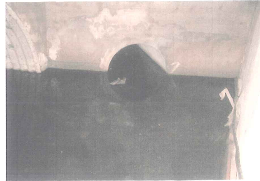
Tubería 1000 mm HA procedente del ramal Este que acomete a la arqueta P2 (*)
