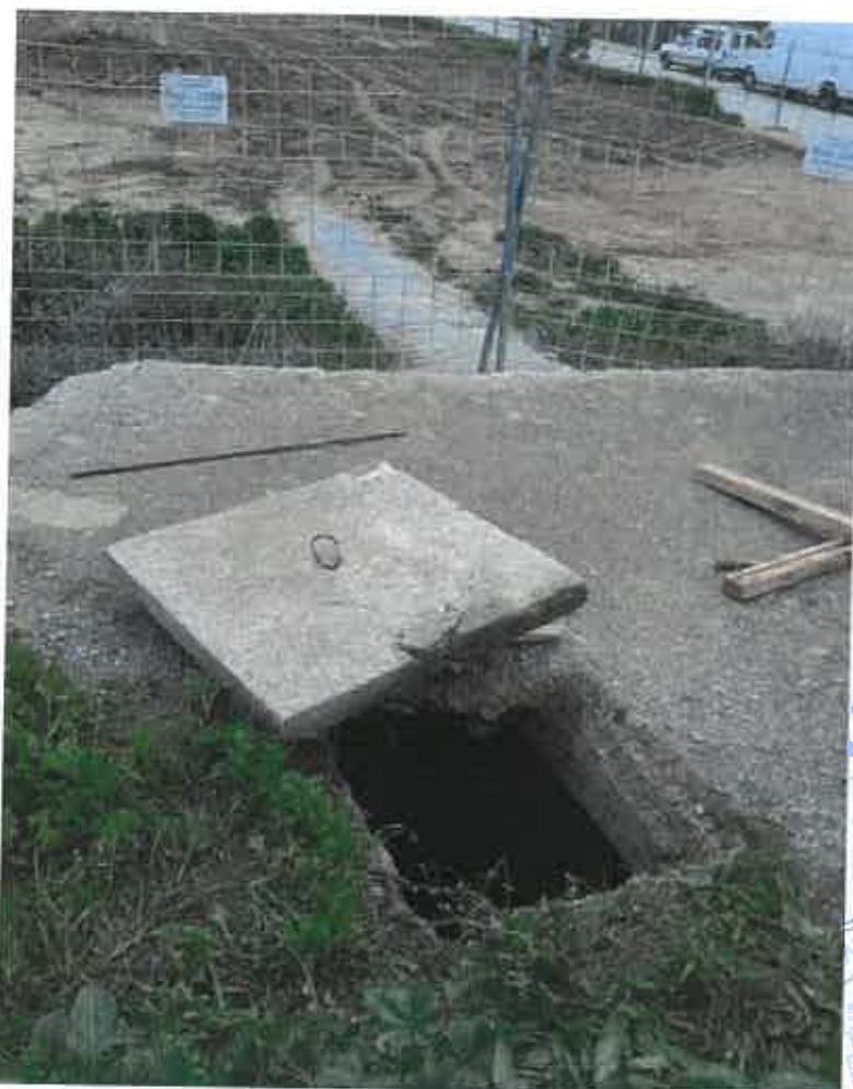
Arqueta de registro P3 y parte superior tubo arco hacia aguas abajo (*).
