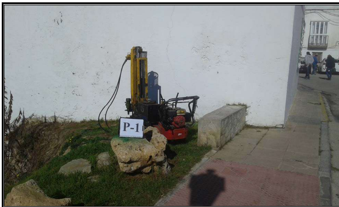
Ensayo de penetración nº1
