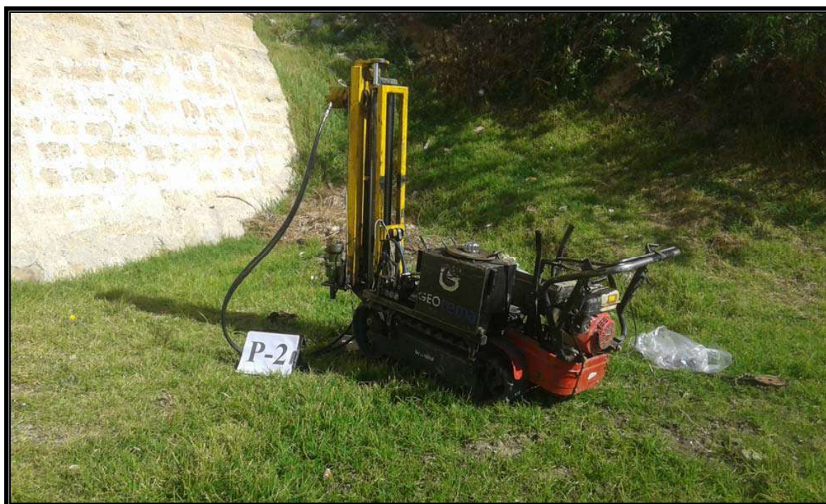
Ensayo de penetración nº2
