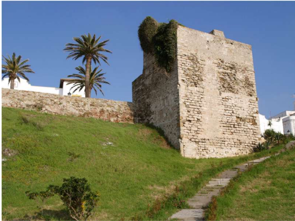
6. Vista general de la Torre del Miramar desde el sur en 2010. Obsérvese la escalera original desmontada.
