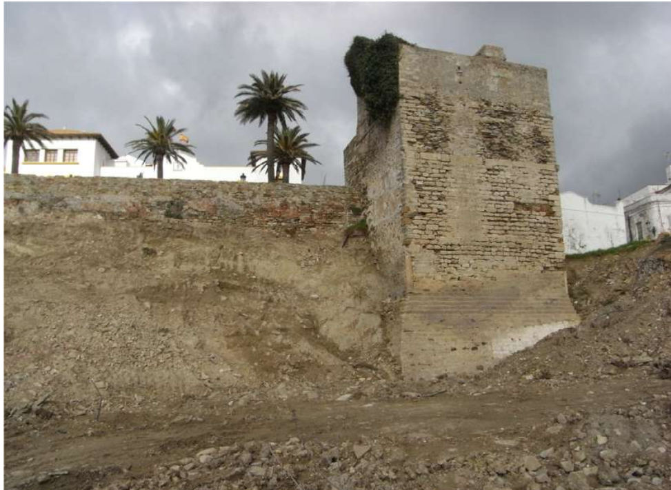
9. Vista del frente sur de la torre tras la excavación en enero de 2011.
