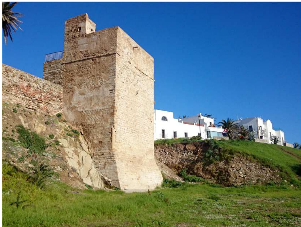
12. Vista de la torre desde el oeste en 2014. Obsérvese el talud del terreno seccionado, dejando mostrar los rellenos recientes que lo forman
