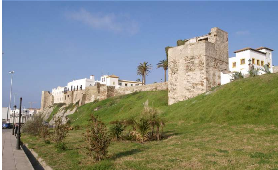
5. Vista general del frente sur de la muralla de la Almedina en 2010.
