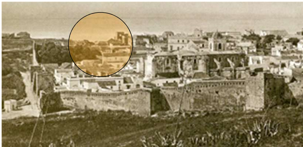
3. Detalle de la Torre del Miramar en la fotografía general de Tarifa de J. Laurent de 1879.
