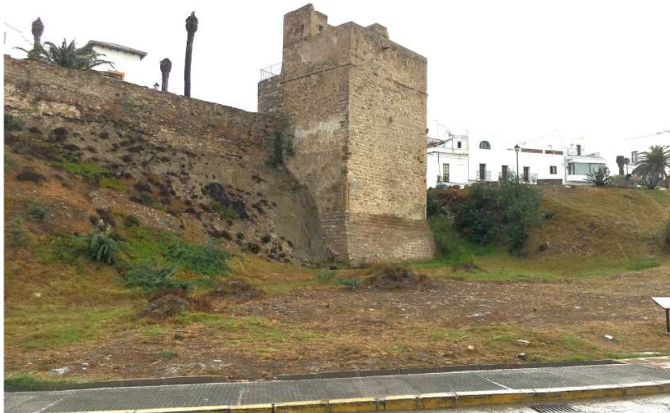
13. Vista de la torre desde el sur en la actualidad (I).
