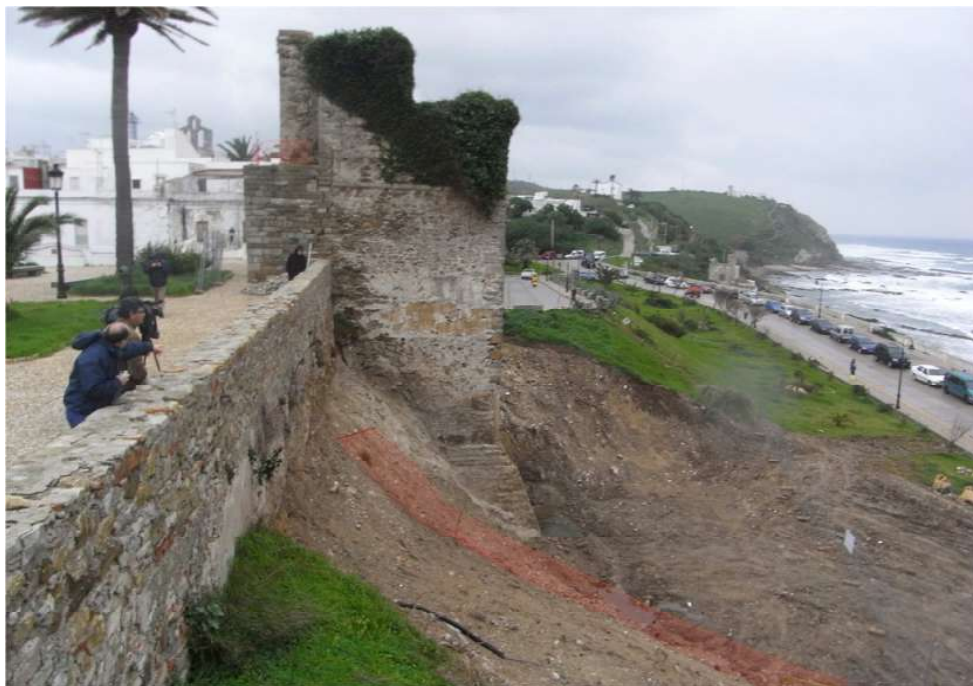
10. Vista del frente oeste de la torre tras la excavación en enero de 2011.
