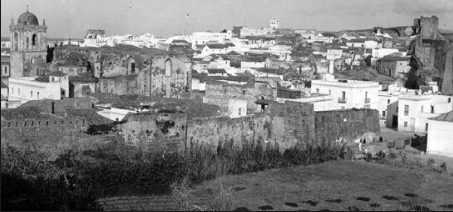
Imagen 1.- Loty, M.A.C.P., Sevilla. Frente este, con el tramo reconstruido donde se abrió la brecha.
