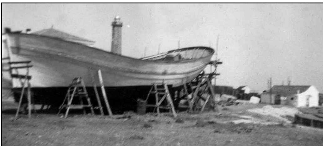
Imagen 2.- El “Ciudad de Tarifa” en construcción (año 1950). Tras de él el faro de Estepona (Málaga).
